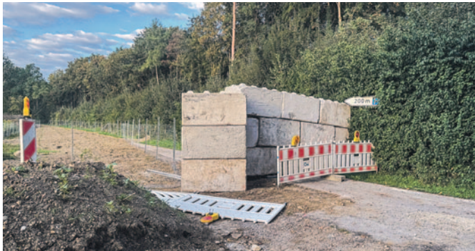
Der versperrte Zugang zum Rothschwaiger Forst von der Seite des Kieswerks: Betonquader und Absperrlemente blockieren den Weg.
